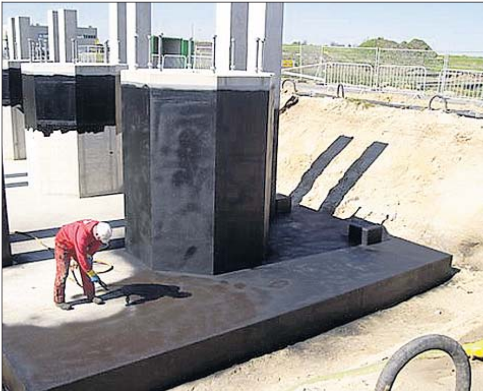
Werknemers van Sijsma uit Zweins waren anderhalf jaar bezig op het Zuidwending-project. Ze beschermden al het nieuwe beton tegen roest.
