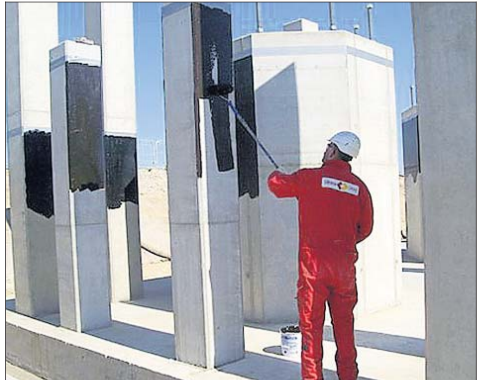
Werknemers van Sijsma uit Zweins waren anderhalf jaar bezig op het Zuidwending-project. Ze beschermden al het nieuwe beton tegen roest.
